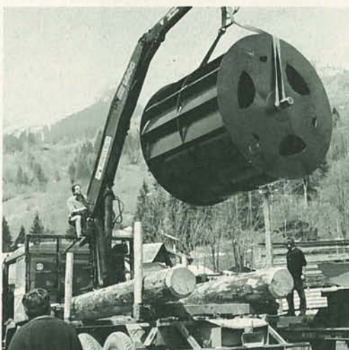
Au moyen d'une grue on a placé la roue à eau en acier dans les paliers.
