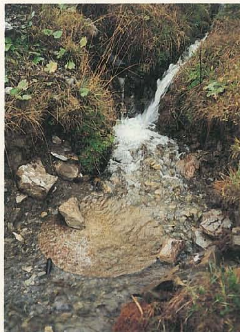
Das überströmte Lochblech der Fassung ist kaum sichtbar. Absichtlich wurde ein rostendes Blech gewählt.
