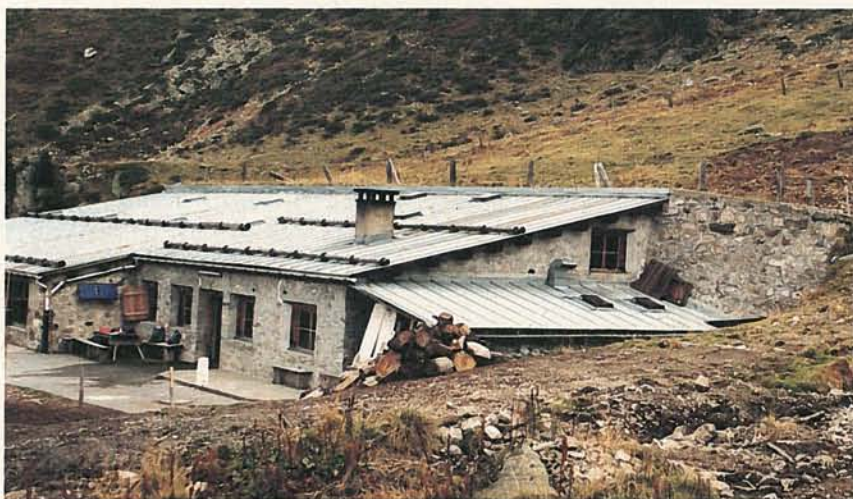
Rechts über der lawinengesicherten Alphütte der Schacht mit der Wasserturbine
