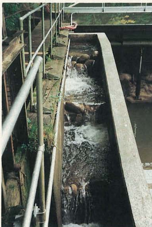
Fischtreppe in Huttwil BE. Während sich in diesem Falle ein Beckenpass aus Beton eignete, ...
