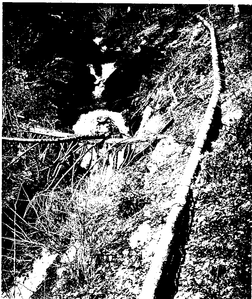
Conduite forcée en acier, diamètre 200 mm, installée en surface dans un terrain escarpé et rocheux
